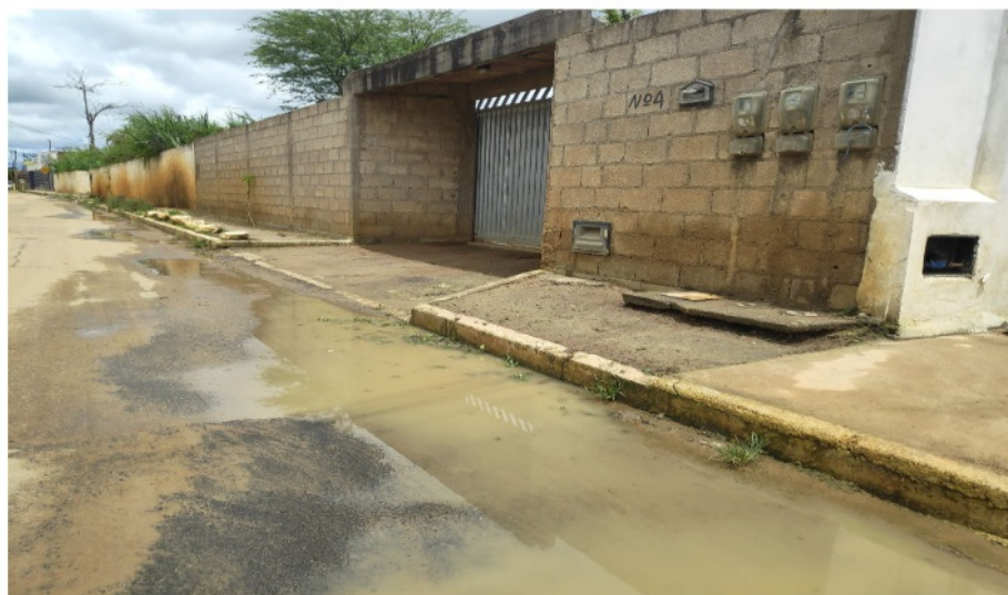
Figura 6: Ausência de sistema de captação de águas pluviais no Bairro Lagoa das Flores.
